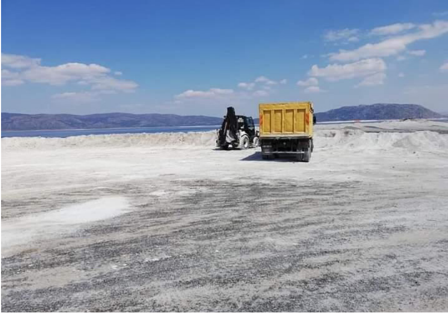
Şekil 21. 13 Nisan 2020 tarihinde göle sokularak millet bahçesi projesi yapımı için çalıştırılan iş makinaları.
