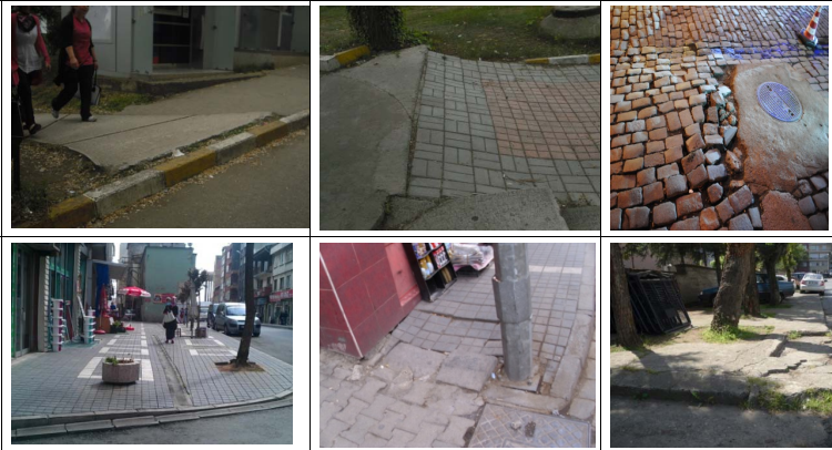
Çizelge 3: Engelli kullanımına uygun olmayan zemin düzlemleri
