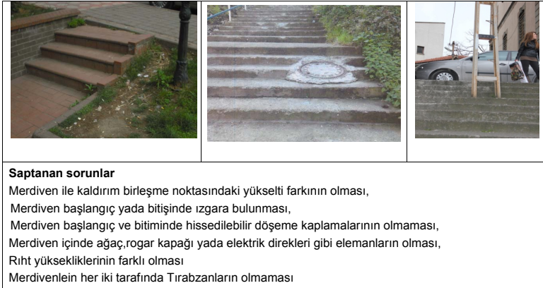
Çizelge 4: Engelli kullanımına uygun olmayan merdivenler
