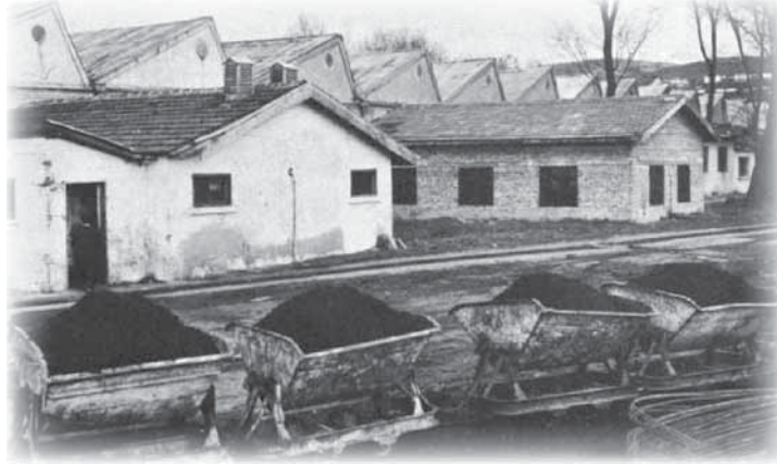
Beykoz Fabrikası'ndan eski bir görünüm (Kaynak: http://kentvedemiryolu.com/ )
