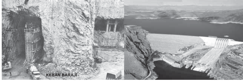
Keban Barajı İnşaatı
