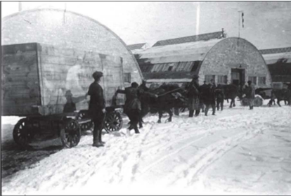
Fabrikanın Biten Hangarları ile Hangarlar içine Monte Edilecek Alet Edevatının Kağnılarla Taşınması
