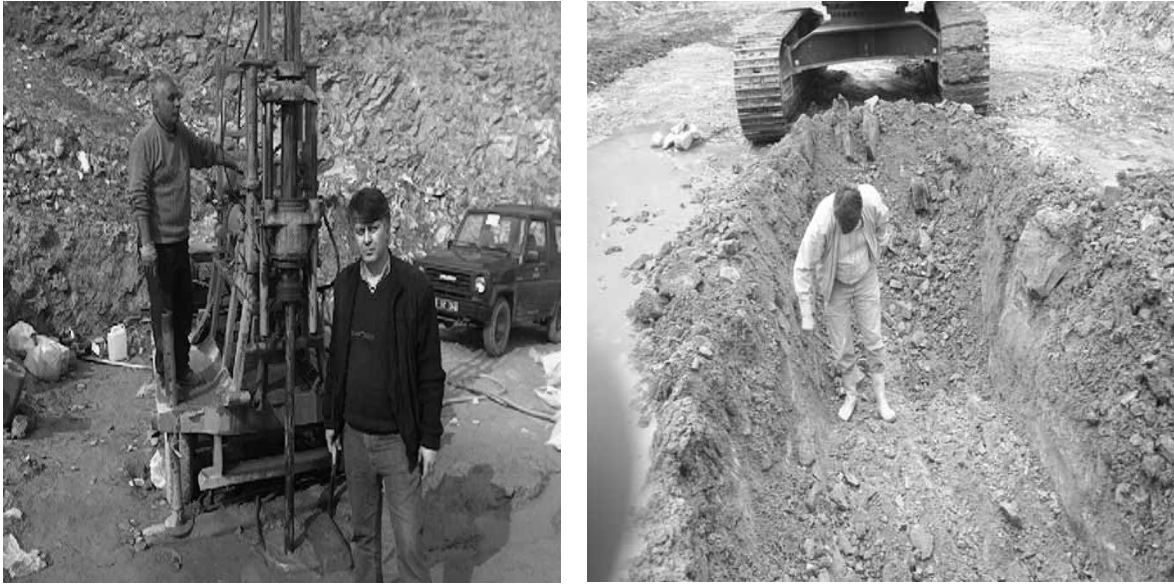
Şekil-2. Yapı denetim mevzuatında, yapı temel parametrelerini belirleyen temel sondajlı jeoteknik etütlerinin yerinde denetimi mutlaka yerelmalıdır. Fotoğraflarda temel sondajın ve açılan yapı temelinin jeoloji mühendisince denetlenmesi görülmektedir.
