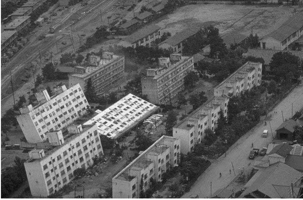
Şekil 4 Sıvılaşma - Niigata Japonya Depremi (1964), Kawagishi-cho Apartmanları
