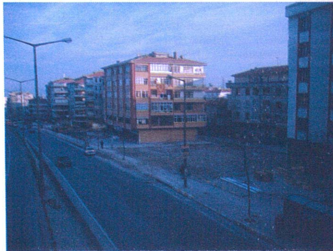
Avcılar'daki yapısal yıkım ve hasarlar E.5 karayolu çevresinde meydana gelmiştir.
