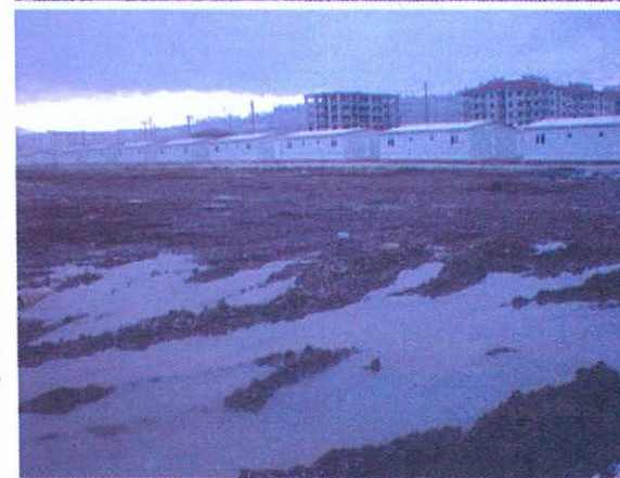
Yalova-Bursa Karayolu kenarında dere yatakları ve sera bahçeleri üzerine kurulan prefabrike konutlar
