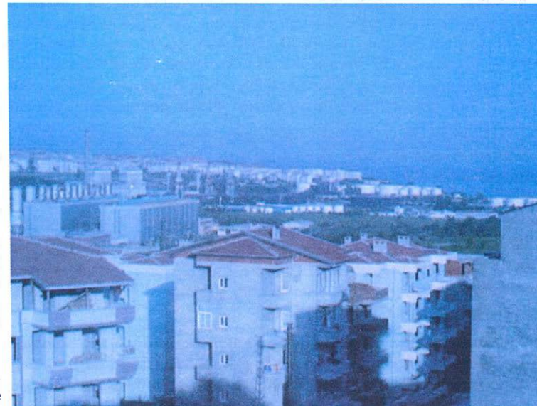
Avcılar Ambarlı dolum tesisleri, fueloil ve doğal gaz santrali, Aygaz depoları ve konutlar
