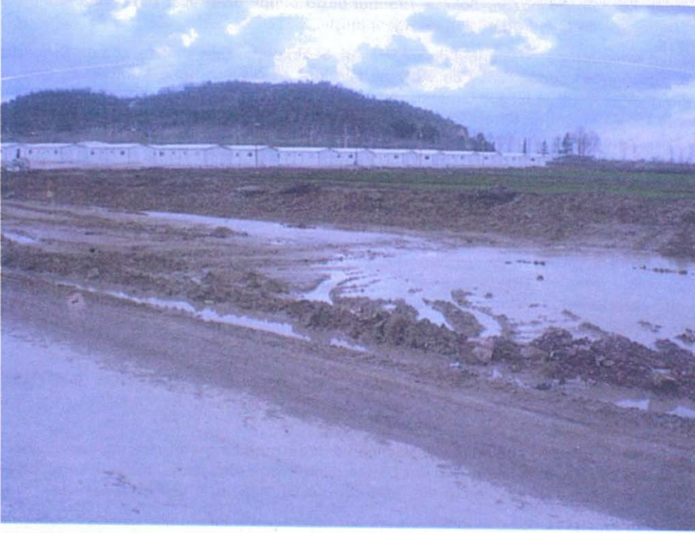
Yalova-Çınarcık karayolu kenarındaki prefabrike konutlar
