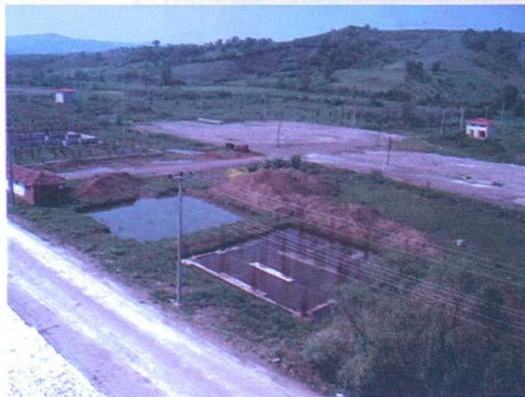
Enkazları yeni temizlenen Hacı Mehmet Ovası, rant uğruna yeniden yapılaşmaya açılmak isteniyor.
