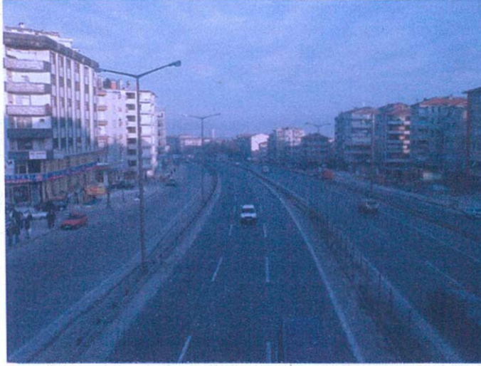
Avcılar'daki yapısal yıkım ve hasarlar E.5 karayolu çevresinde meydana gelmiştir.
