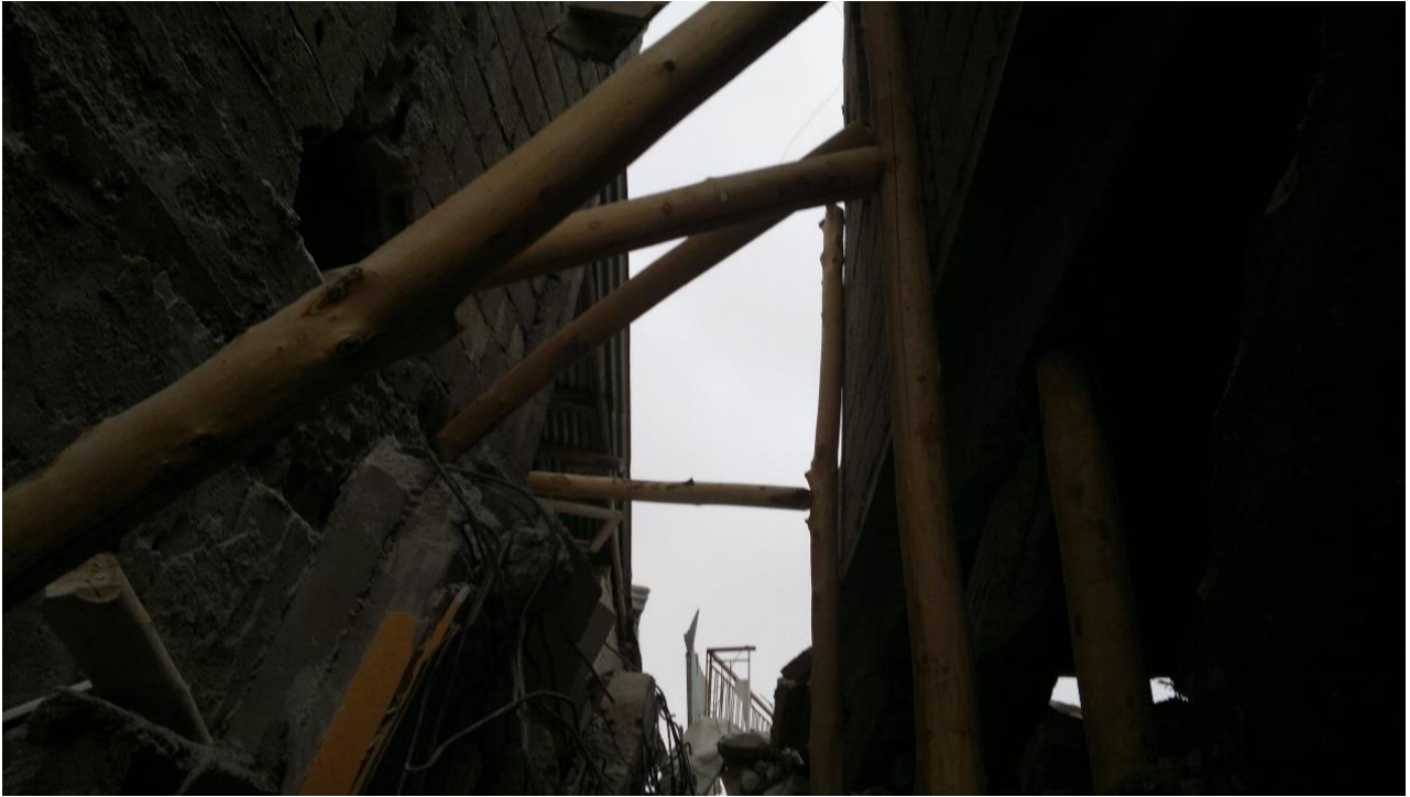
Van-Erciř, Galeri ama yntemiyle binaya giriř yapmadan nce yıkılma tehlikesi bulunan binanın duvarı ile yan bina duvarı arasına tahkimat yapılmıřtır. (TTK Kozlu Messesese arama-kurtarma ekibi)
