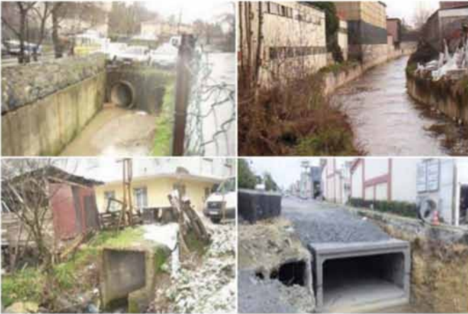
Fotoğraf 2. Daraltılarak ishah edilmiş dere yatakları
