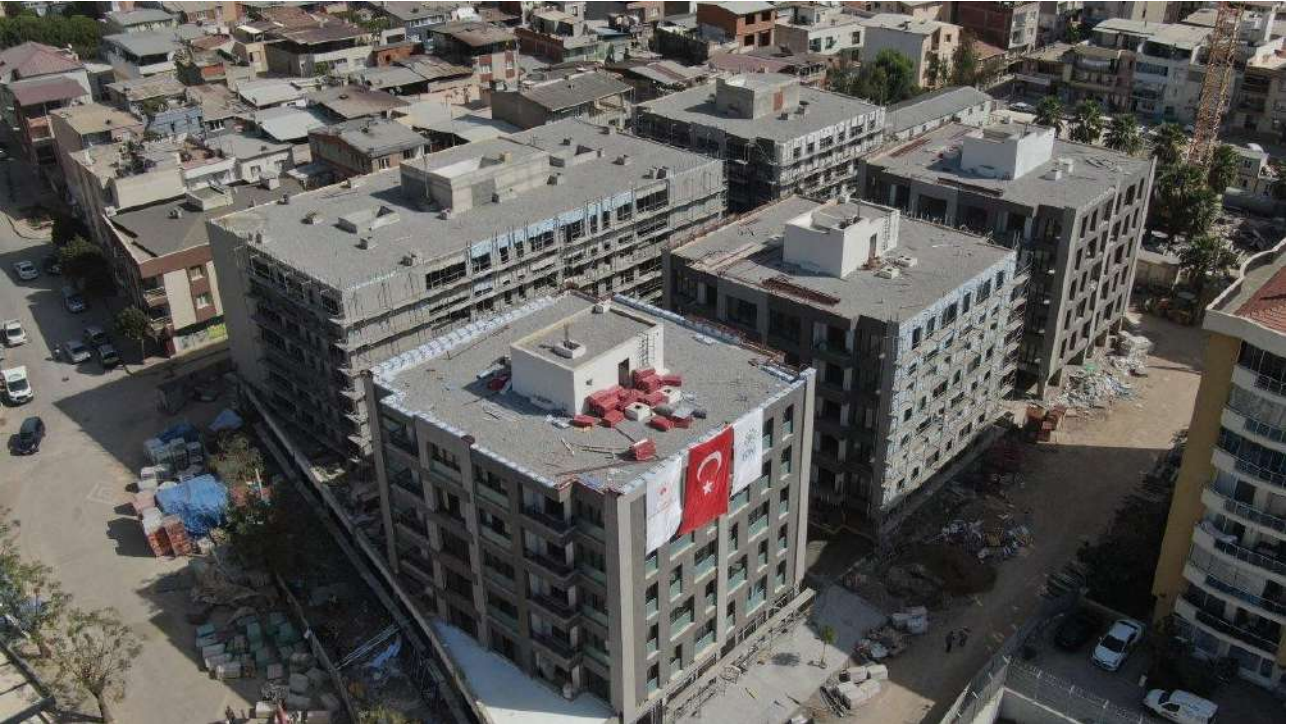
Şekil 7. Bayraklı'da yıkım yaşanan bölgeden proje örneği (İHA, 2021)
