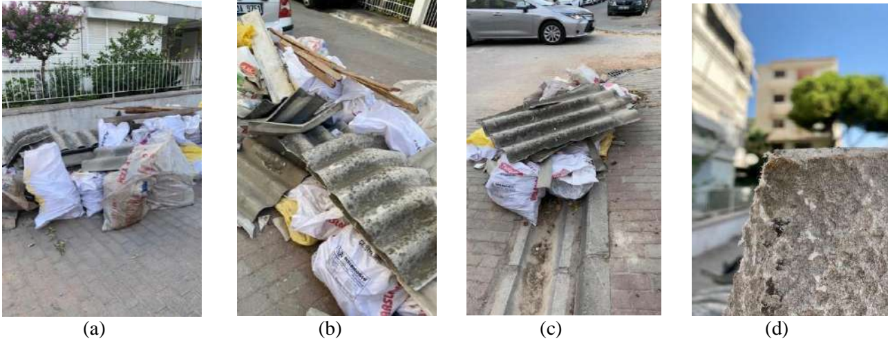
Şekil.14 a,b,c,d Yaşadığımız şehrin sokaklarına binalardan söküldükten sonra kırılarak atılan eternit çatı kaplamaları
