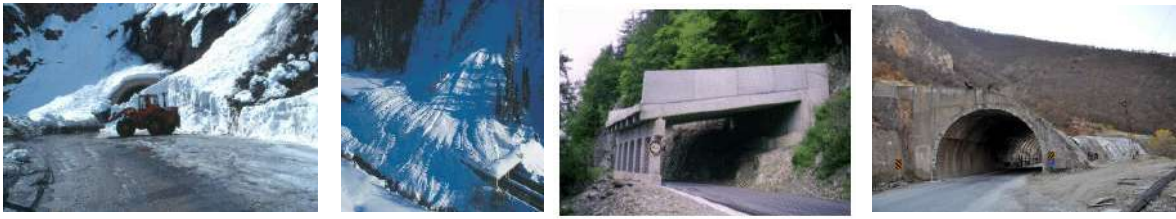
Şekil 12. Çığ Tünelleri (Gürer, 1992) ve Karşılan İşletme Problemleri (Tunceli-Erzincan karayolunda bulunan tünellerin bir bölümü uzatılıyor.) (İnternet, 2022)
