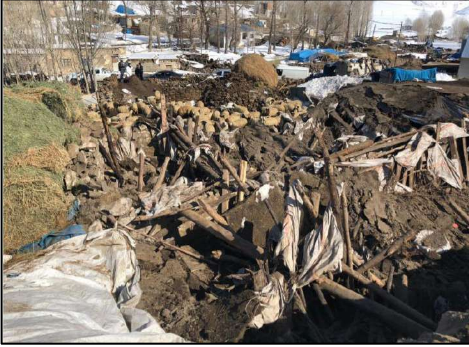
Şekil 19. Hayvancılık Yapan Yöre Halkının Deprem Sonrası Ahırlarının Durumu (Kaynak: Url-29)
