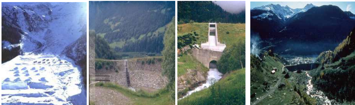
Şekil 9. Akan ıęı Dağıtmak, ıęı Durdurmak ve Yazın Suyu Kullanmak Amacıyla Kar Depolama Barajları (SFISAR, 1992 ; ANENA, 1994)
