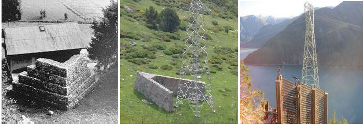
Şekil 10. Akan Çığın Rotasını Saptırmak Amacıyla Farklı İnşaat Malzemeleriyle Yapılan Mahmuzlar (Çığkırınlar) (ANENA, 1994)
