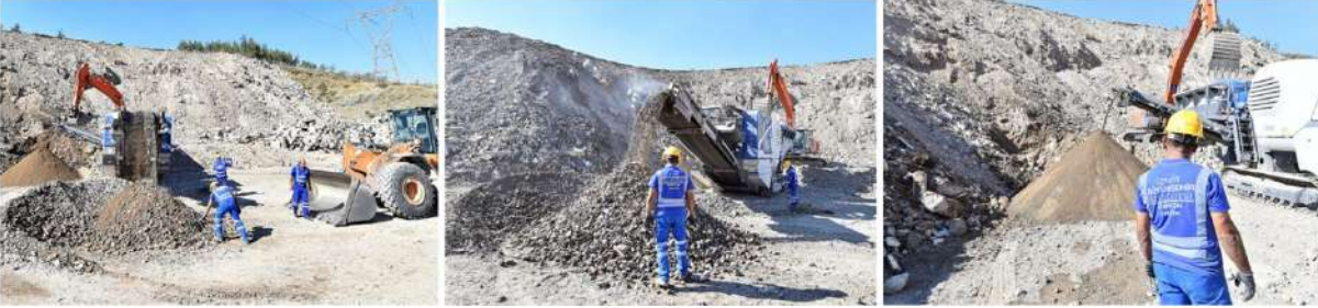
Şekil 12. İZBETON Berber Salih inşaat ve yıkıntı atıkları geri dönüşüm tesisi
