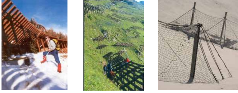
Şekil 11. Çığ Başlangıç Bölgesinde; Teraslama, Şaşırtmacalı Kazıklar, Tripotlar, Yatay veya Düşey Latalı Bariyerler, Çığ Ağları (USDA,1961; SFISAR, 1992; Gürer, 2015; Gürer, 2018)
