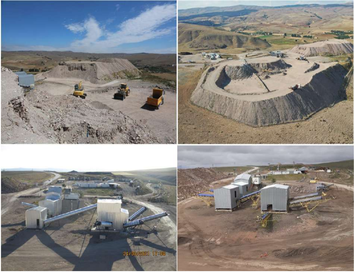
Şekil 13. Eskişehir Büyükşehir Belediyesi inşaat ve yıkıntı atıkları geri dönüşüm tesisi
