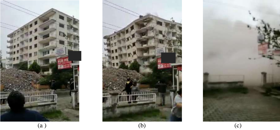
Şekil 19. a, b, c Hasarlı binaların yıkımı
