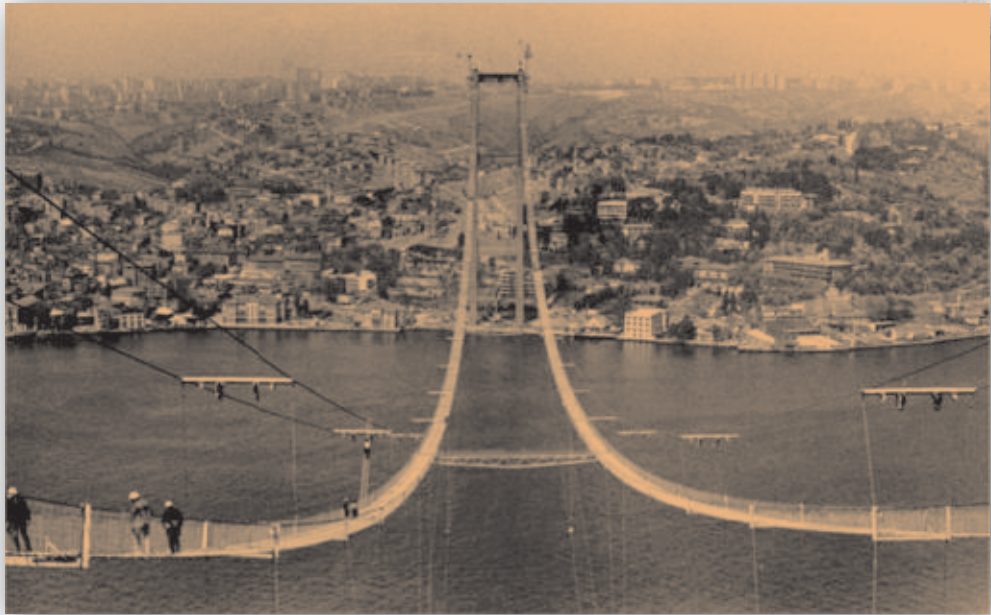
Boğaz Köprüsü inşa halinde
