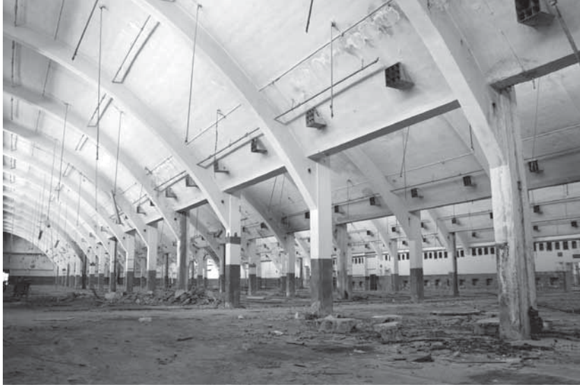
İşletme Binasının İçi, 2011
